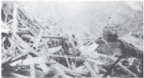
La Mina destruida.
