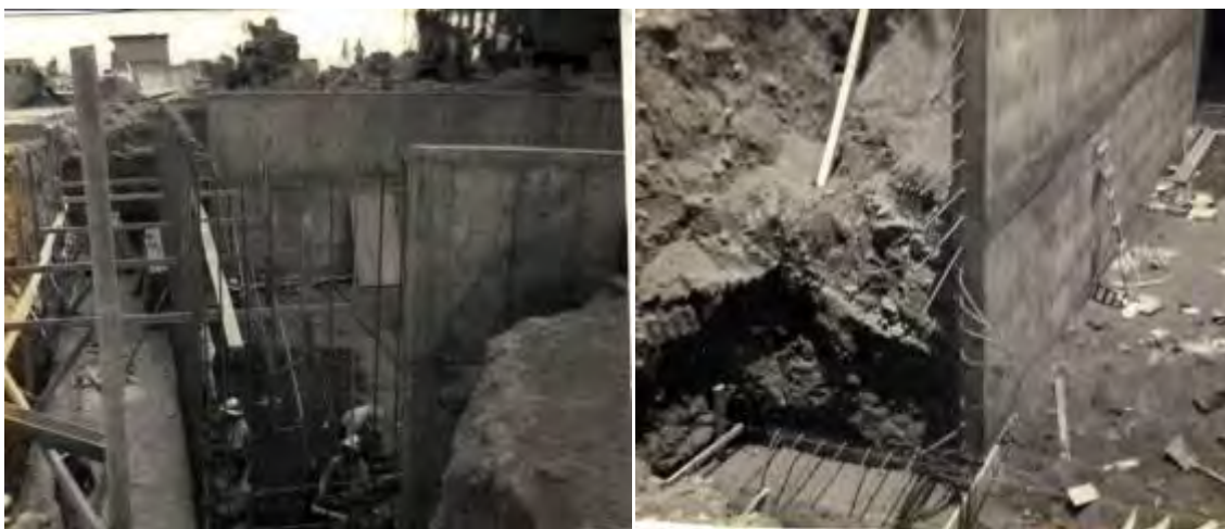
Fundaciones de concreto reforzado, 1968 Muro reforzado de las fundaciones, 1968
