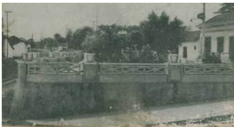
Antiguo Parque Fray Bartolomé de las Casas, sus ruinas todavía se observan sobre la carretera norte antes de llegar a ENABAS
