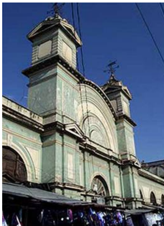
Portón de entrada al Mercado, fachada norte
