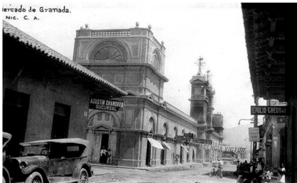
Fachada norte del edificio del Mercado de Granada
