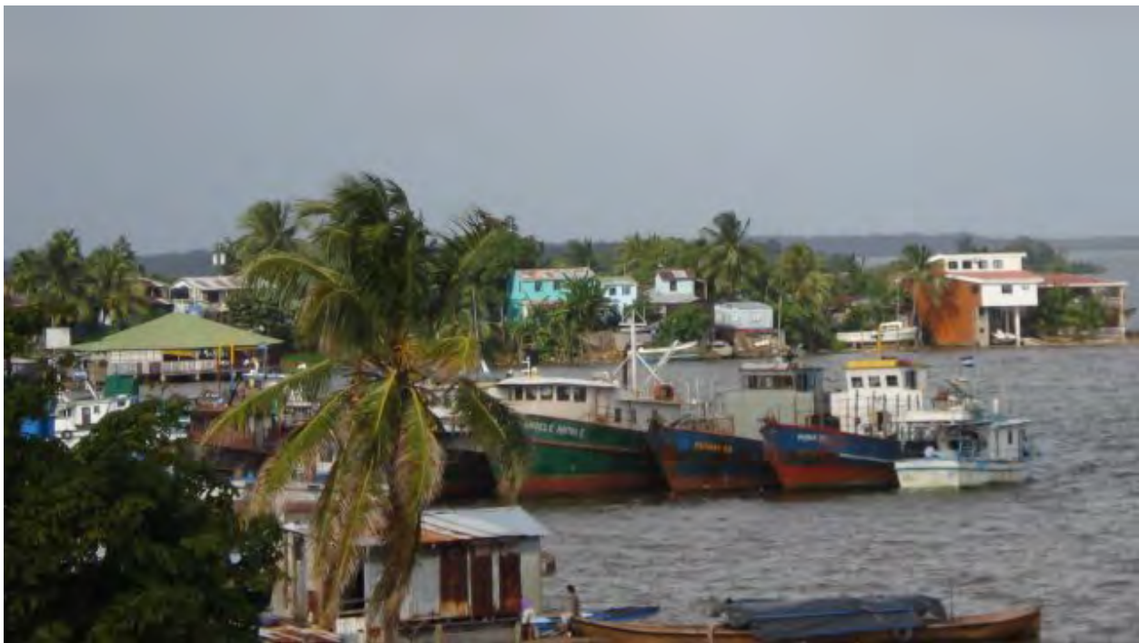
Vista del puerto de Bluefields. Fuente: Heberto Jarquín. Apagón afecta a la RAAS. El Nuevo Diario. 21 de julio de 2009
